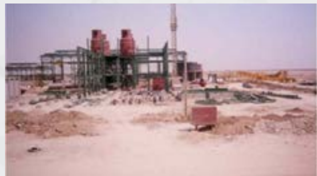
تصاویری از مراحل ساخت کارخانه شکر توسعه نیشکر
